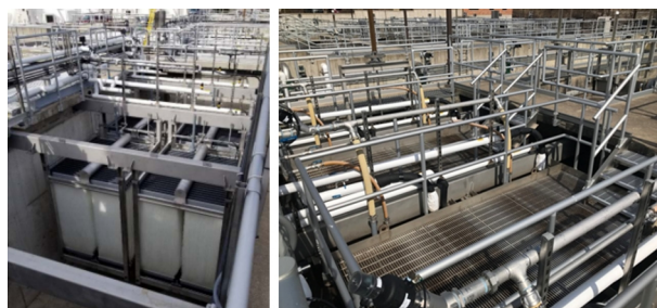
图 3 YBSD 污水处理厂 MABR 膜池 [23]
